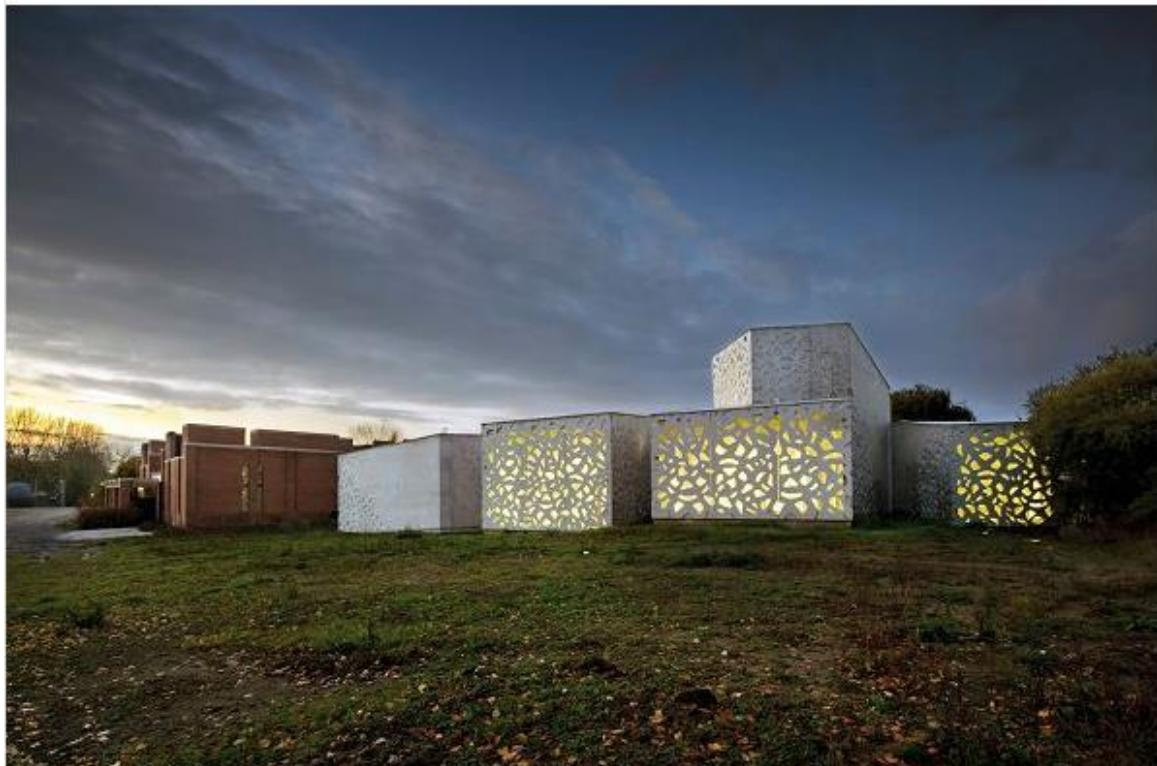
Кто-то ставит на стекла специальные мембранны, кто-то использует регулирующие потоки света жалюзи. Архитектор [Мануэль Готран](#) выбрала другой путь: вместо светового фильтра она закрыла окна новых галерей ажурными экранами из ультралегкого волокнистого бетона. Узор рассчитан
