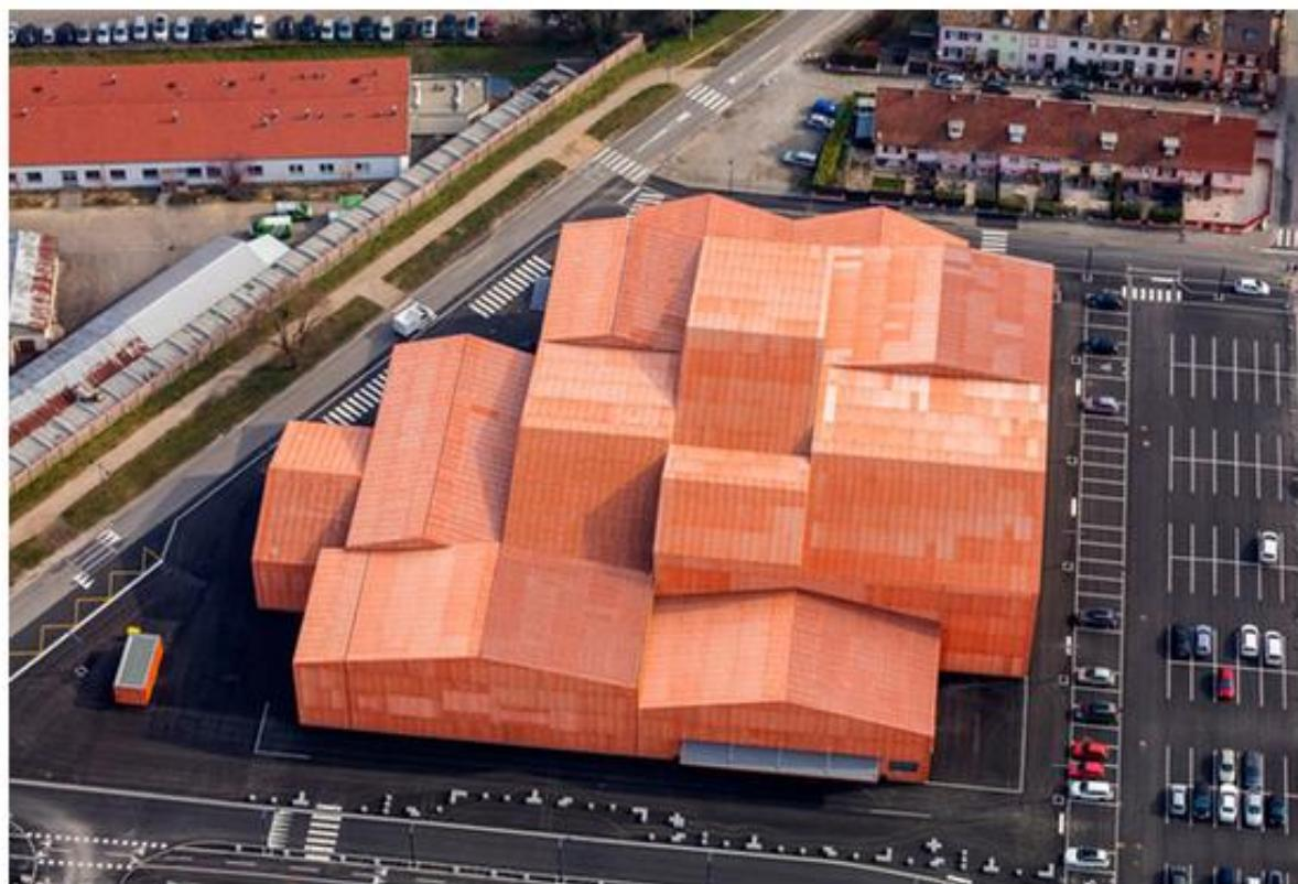
В комплексе представлено 13 объемов: самые небольшие из них расположены по краям, а наиболее крупные находятся в центре. При этом все они выдержаны в едином стиле, выполнены из одних и тех же строительных материалов и накрыты одинаковыми двускатными крышами характерного для этой местности дизайна.
